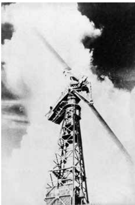
"Smith Putnam Wind Turbine", der blev forløber for nutidens MW-møller allerede i 1940'erne. (Foto: NREL)
