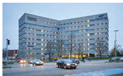
Gladsaxe Company House fra 2015 har energimærke A, men ved at udnytte internetbaseret teknologi med data i høj opløsning kan bygningen blive endnu mere energieffektiv. Foto: NCC.
